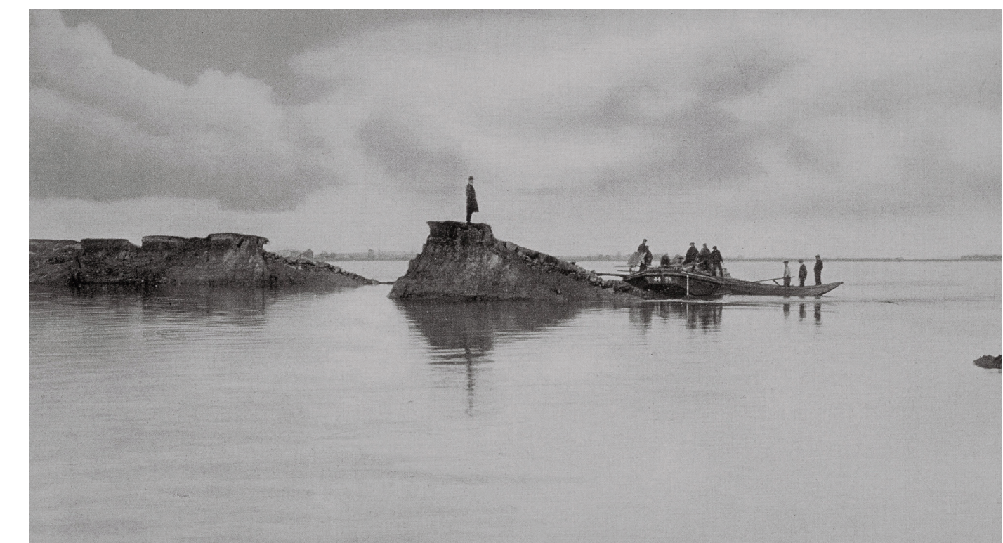
Percée lors de la catastrophe des inondations de Zuiderzeedijk Source : https://www.rijkswaterstaat.nl/
